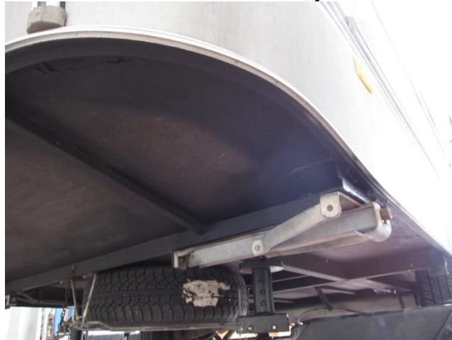
Wohnwagenboden: Hier massive Spanplatte, spärlich geschützt
