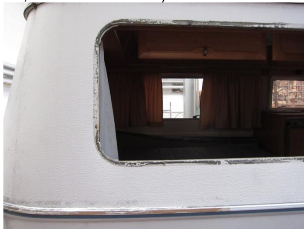
Drei mögliche Schwachstellen auf einen Blick: Dachabdichtung, Fensterabdichtung und Verbindungsnaht oberer zu unterer Aufbau. Hier war ursächlich: Alte und poröse Fensterdichtung
